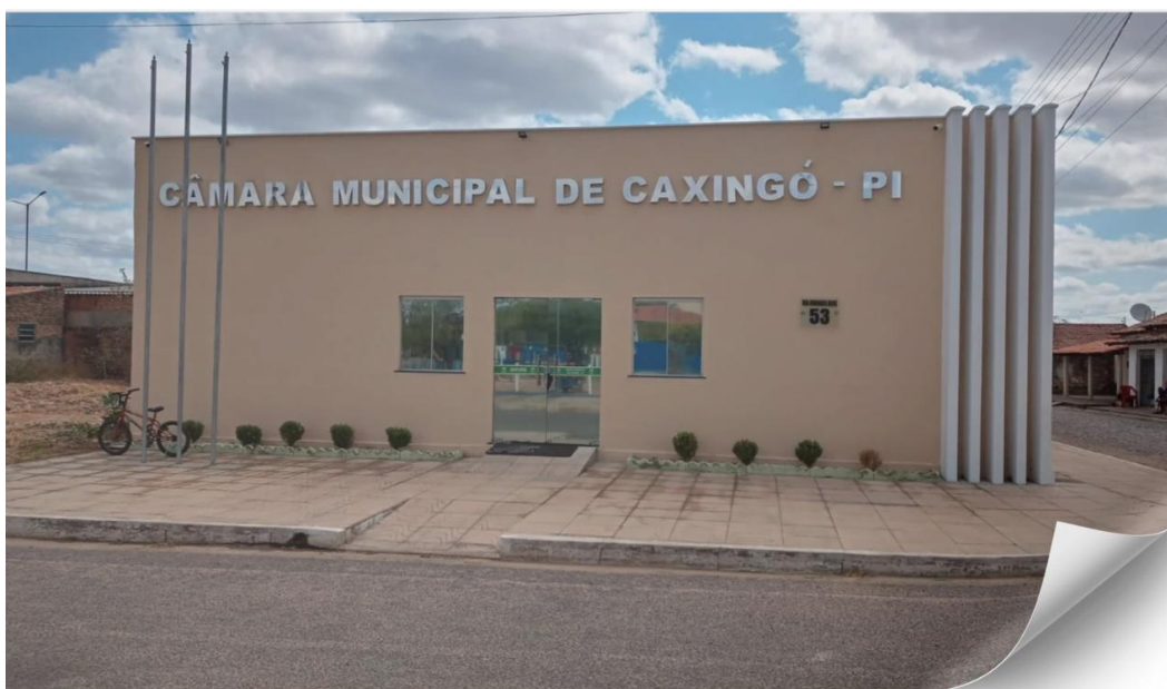
Figura 2 – sede da Câmara Municipal (visão externa)
